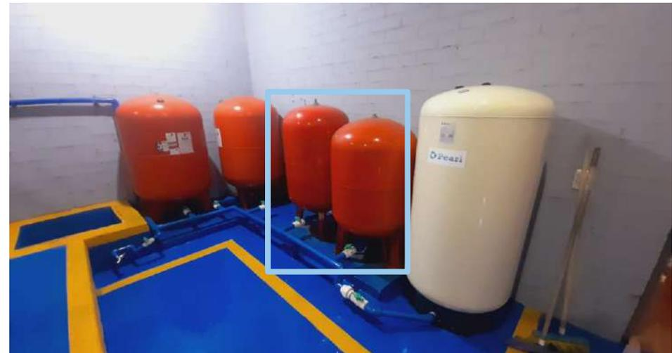
**Figura 5.** 2 tanques LA300 serán reemplazados 1 LA500.
